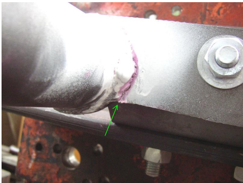
Foto č 2. Nekvalitný zvar priečnika k bočnici ťažného zariadenia. Na bočnici boli vruby od rezania materiálu, čo tiež spôsobilo predčasný lom pri únavovej skúške.
